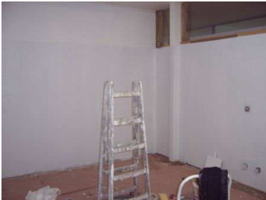
A fibreglas wallcovering ist sticked on the surface of X-Shield
